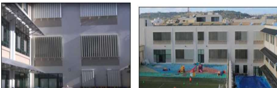
Figura 3: Luvers vertikali esterni li jistgħu jiċċaqalqu kkontrollati mill-BMS fuq il-faċċati tal-Lvant u tal-Punent
