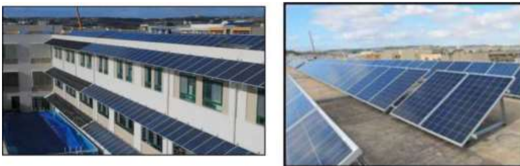
Figura 2: Sistema termali solari tal-pixxina mhux igglejżjata u l-fotovoltajċi tagħti għall-fuq il-faċċata tal-biċċa tan-naħa t'isfel (immaġni tax-xellug) u Fotovoltajċi installati fuq il-bejt (immaġni tal-lemin)
