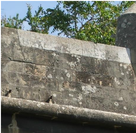
Fig. 30: Face section of left batardeau.
