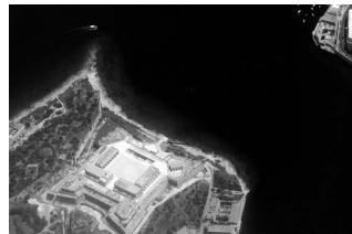
Fig. 2b: Oblique Imagery Fort Manoel 2011
