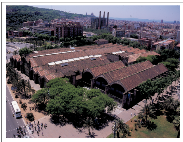
Vue aérienne du bâtiment aujourd'hui.
