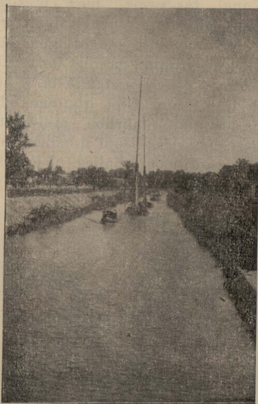
L-Eġittu — Dehra ta' biċċa mill-Kanal tas-Swejz.
