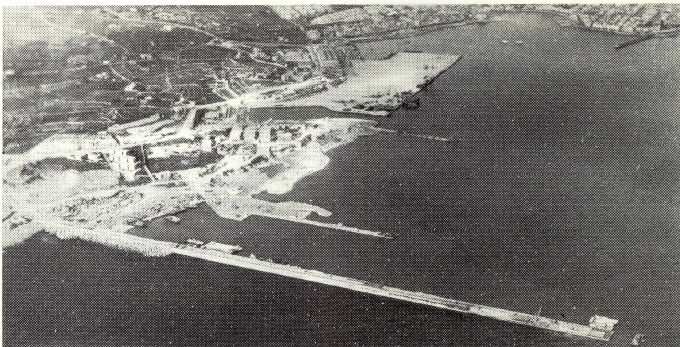
L-aħħar fażi tax-xogħol fuq il-"breakwater" tal-proġett tal-Port ta' Marsaxlokk.
