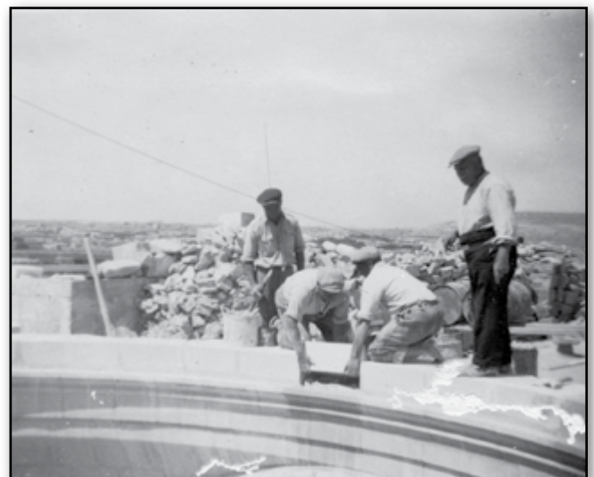
Jitqedu aktar ċnagen fiċ-ċinturin tal-koppla f'April 1947.
