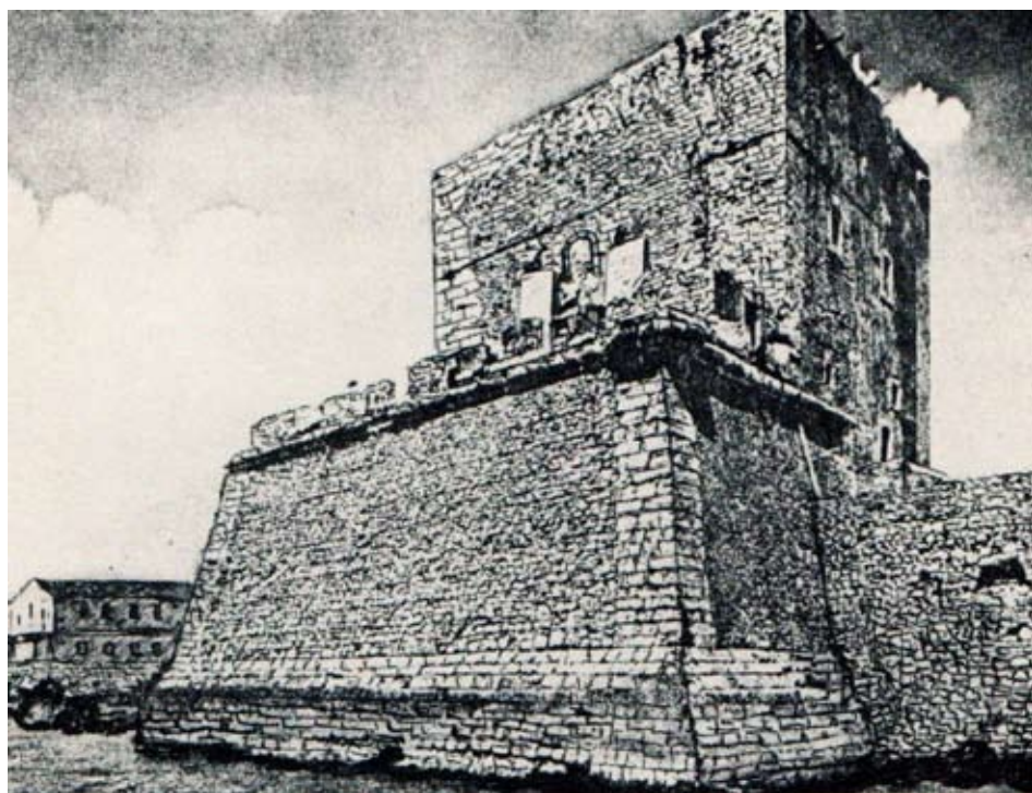
Torre Cabrera, Pozzallo. The seat of Bernat Cabrera.
