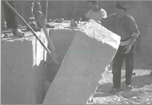
It-tqattiegħ tat-traversi u tal-ġebbla skont id-daqs mixtieqa. Kollu xogħol ta' ċenċil ta' spnajjar f'mazzez kbar, koordinat bejn ħafna nies (ritratti British Pathé)
