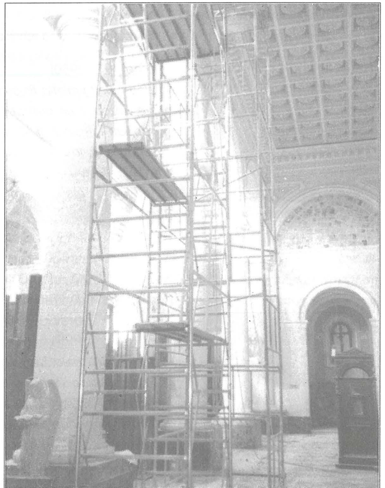
Xogħol fuq l-istalazzjoni ġdida ta' l-elettriku
