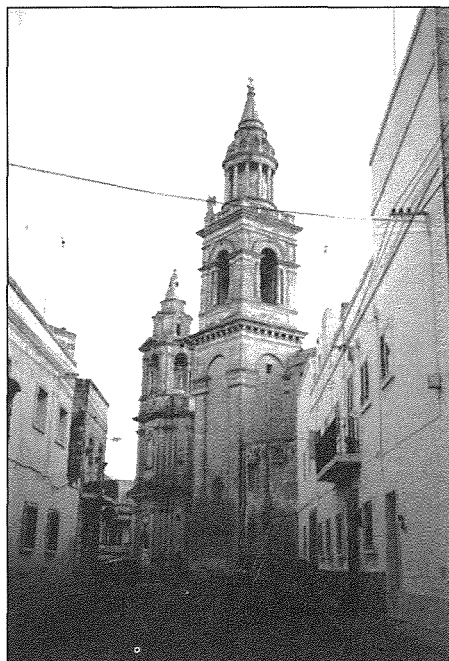
1. L-istruttura kollha minn Triq William Baker
