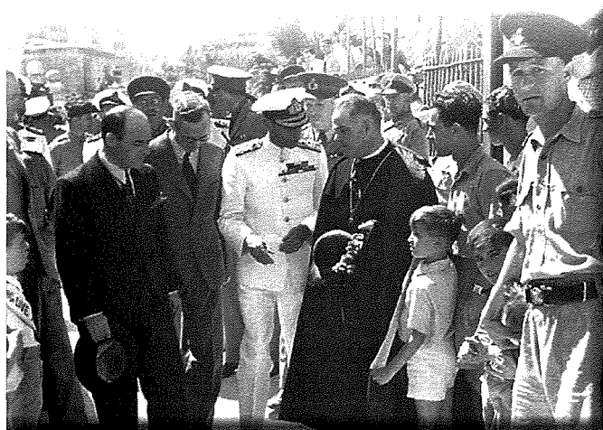
L-Arċipriet, il-Kan. Emanuel Brincat, jilqa' lir-Re Ġorg VI hdejn Dockyard Terrace.
