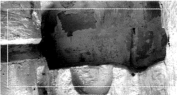
It-tqattigh fil-ħajt biex akkomoda l-makkinarju tad-daqq.
