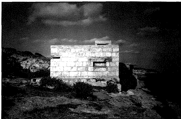
Il-pillbox li hemm f'Ta' Qassisu. Din inbniet mill-gebla tal-franka.
