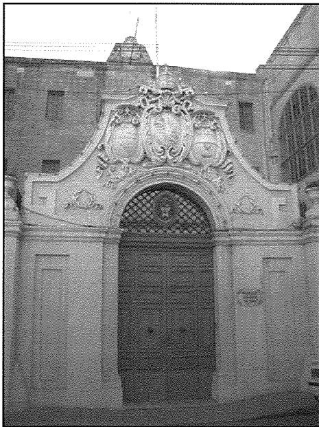
Dehra minn barra tas-Seminarju ta' l-Isqof ġewwa l-Belt Victoria, Għawdex. Dan kien l-Isptar ta' San Ġiljan qabel ma' ngħalaq fl-1864.
